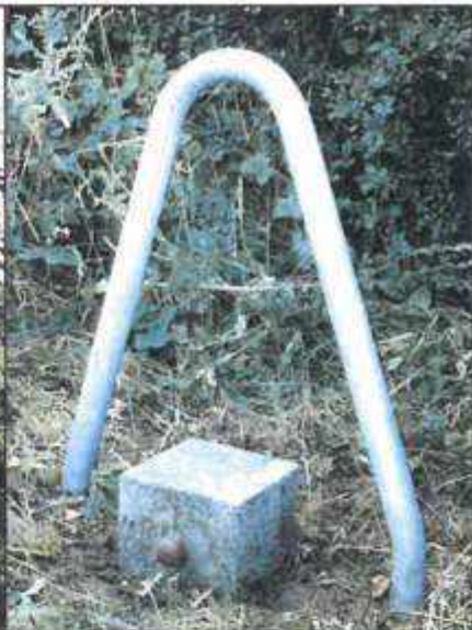
HFP Granitpfeiler 25 cm x 25 cm mit seitlichem Bolzen und Stahlenschutzbügel
