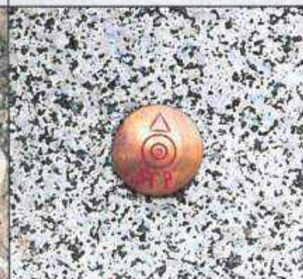
SFP Messingbolzen Ø 3 cm
